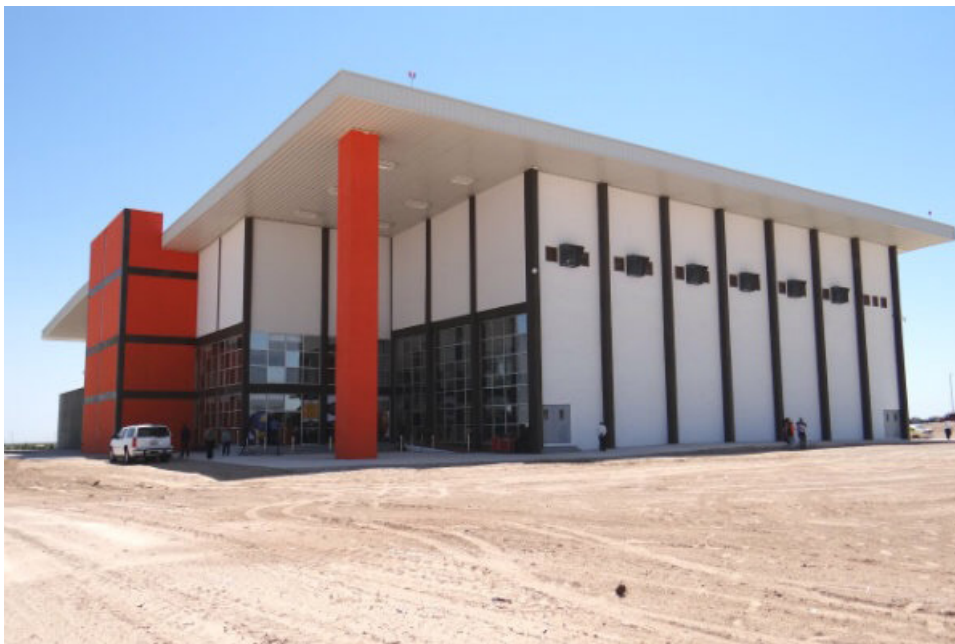
Gimnasio de Usos Múltiples DMCU.
