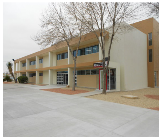
Edificio C del ICB.
