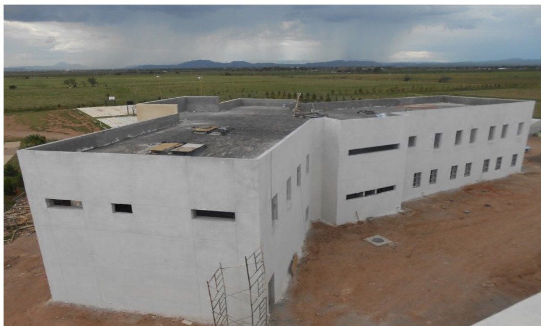
Edificio multifuncional "E" en la DMNCG.
